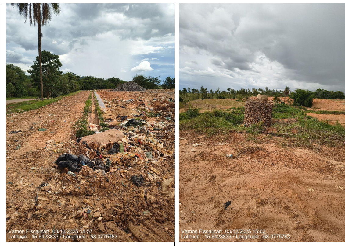
Figura 10 - FONTE: Fiscalização Agerr Pantanal (2025).
