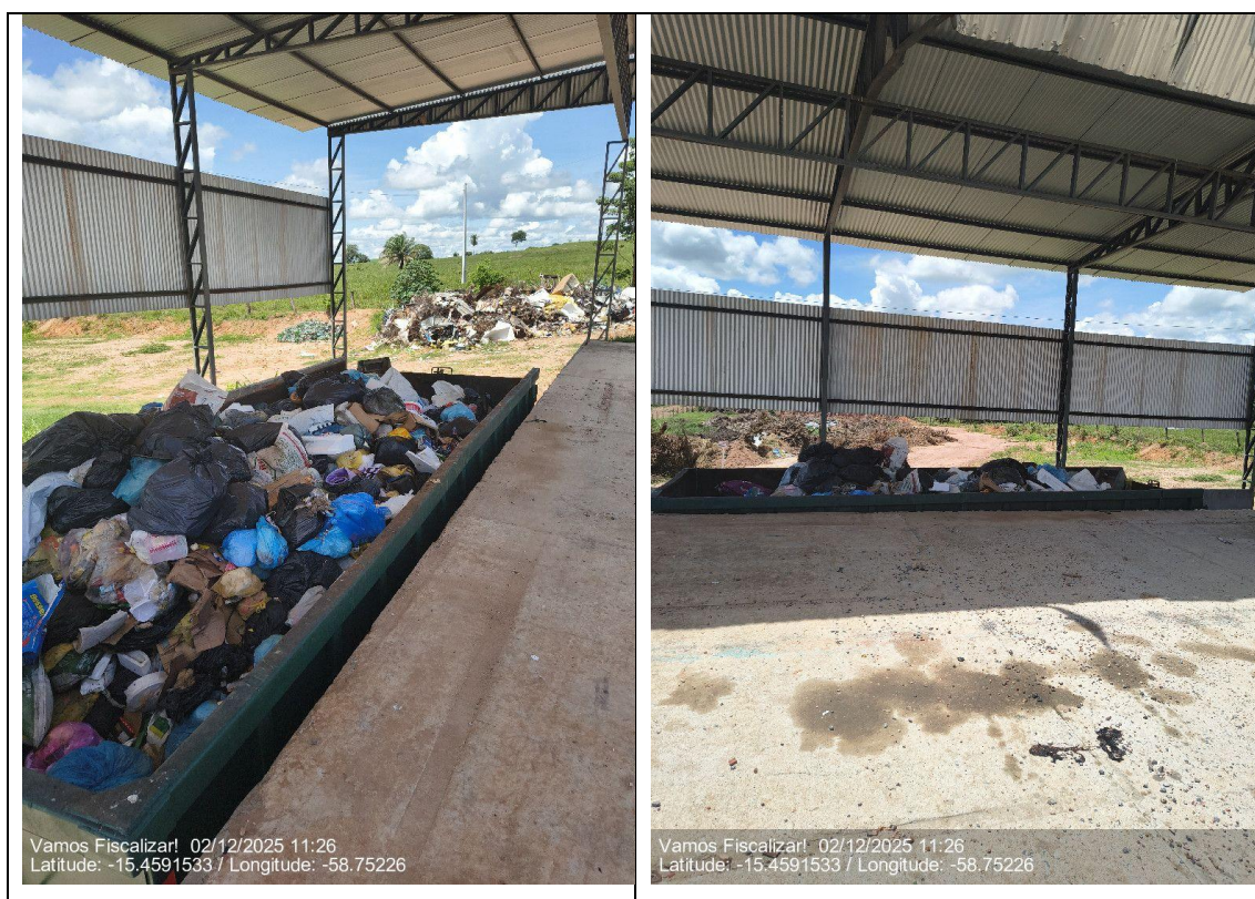
Figura 18 - FONTE: Fiscalização Agerr Pantanal (2025).
