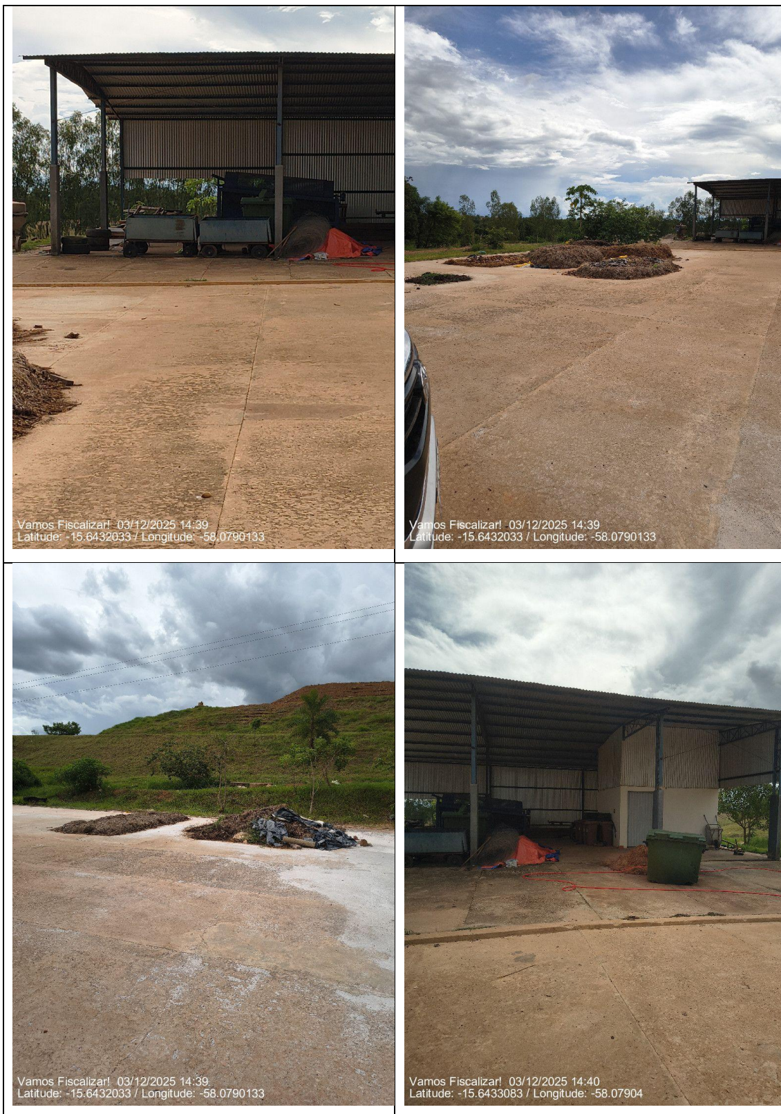
Figura 8 - FONTE: Fiscalização Agerr Pantanal (2025).
