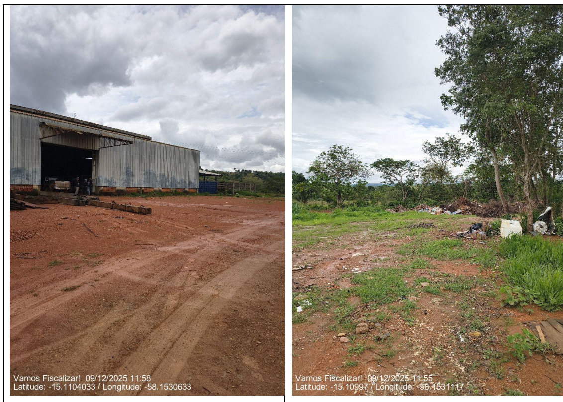
Figura 15 - FONTE: Fiscalização Agerr Pantanal (2025).
