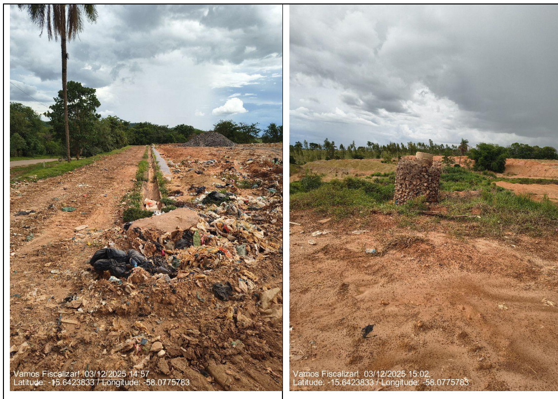
Figura 10 - FONTE: Fiscalização Agerr Pantanal (2025).
