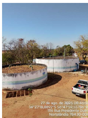
Figura 06: Identificação dos reservatórios na ETA.
