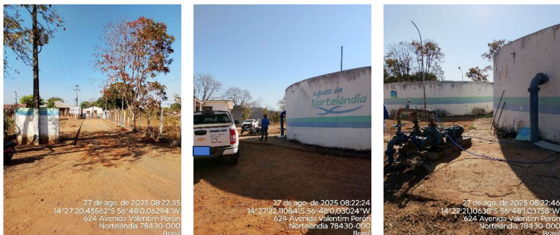
Figura 02: identificação da área da ETA.
