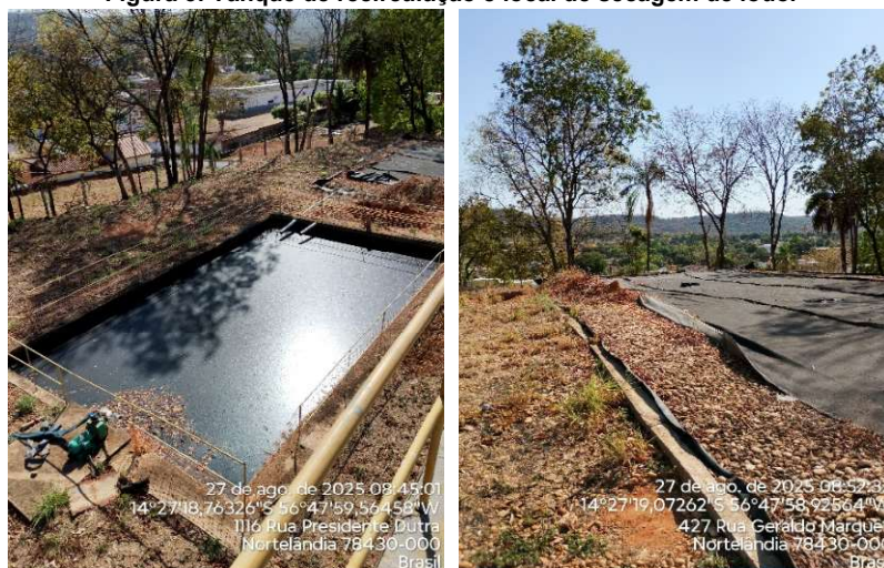
Figura 3: Tanque de recirculação e local de secagem de lodo.
