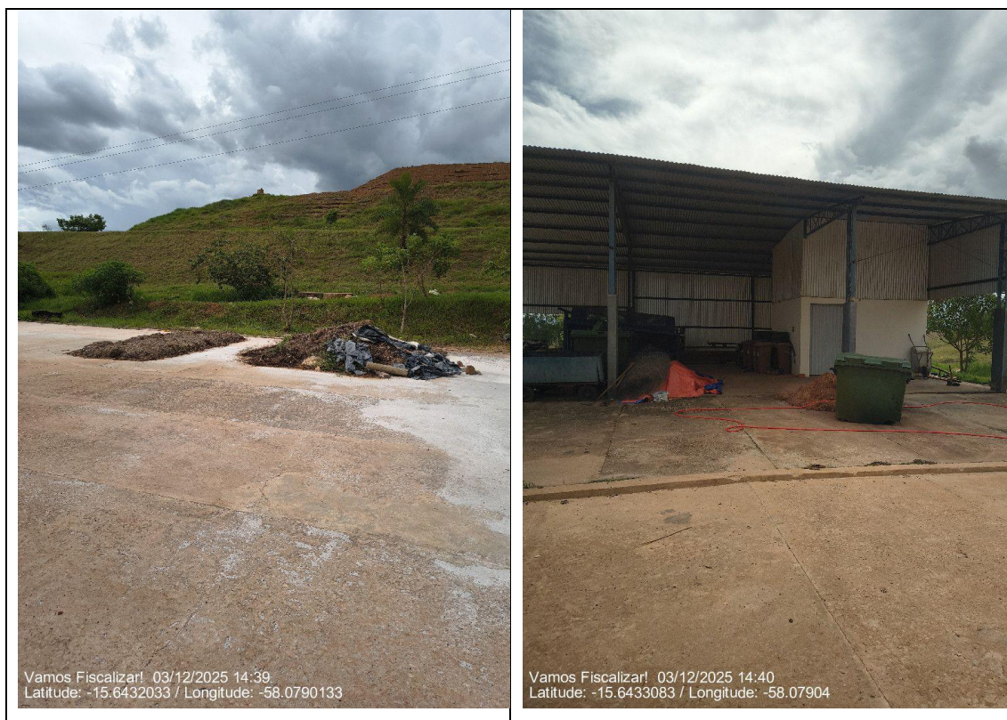
Figura 8 - FONTE: Fiscalização Agerr Pantanal (2025).
