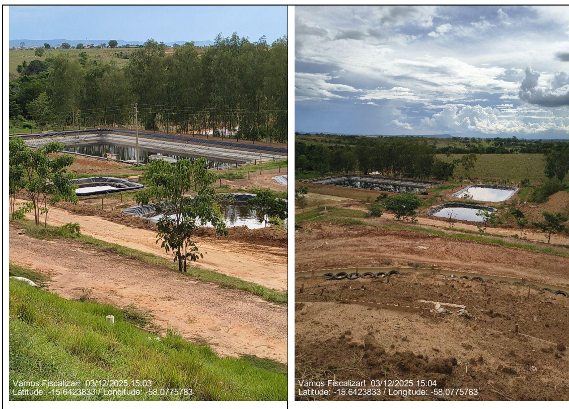
Figura 11 - FONTE: Fiscalização Agerr Pantanal (2025).
