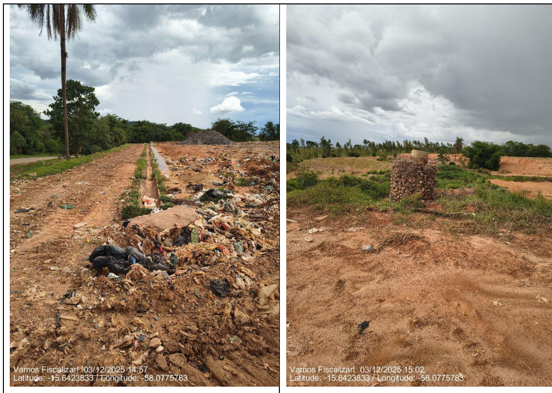
Figura 10 - FONTE: Fiscalização Agerr Pantanal (2025).
