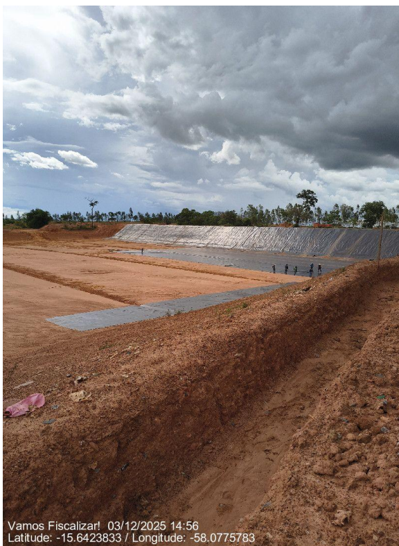
Célula em construção aterro
