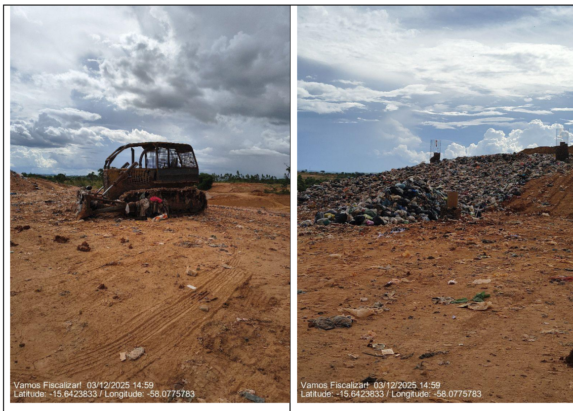
Figura 9 -FONTE: Fiscalização Agerr Pantanal (2025).
