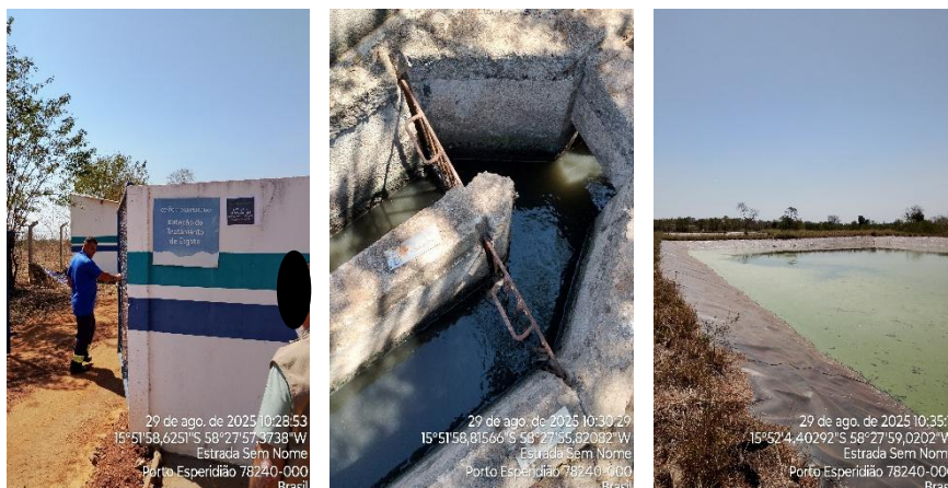
Figura 05: Identificação da ETE de Porto Esperidião/MT.
