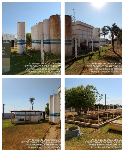
Figura 02: identificação da área da ETA de Porto Esperidião.
