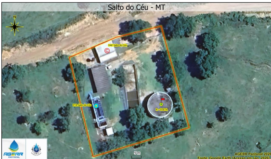
4 – Mapa Salto do Céu – MT - Localização ETA – Estação de Tratamento de Água - SIG AGERR Pantanal.
