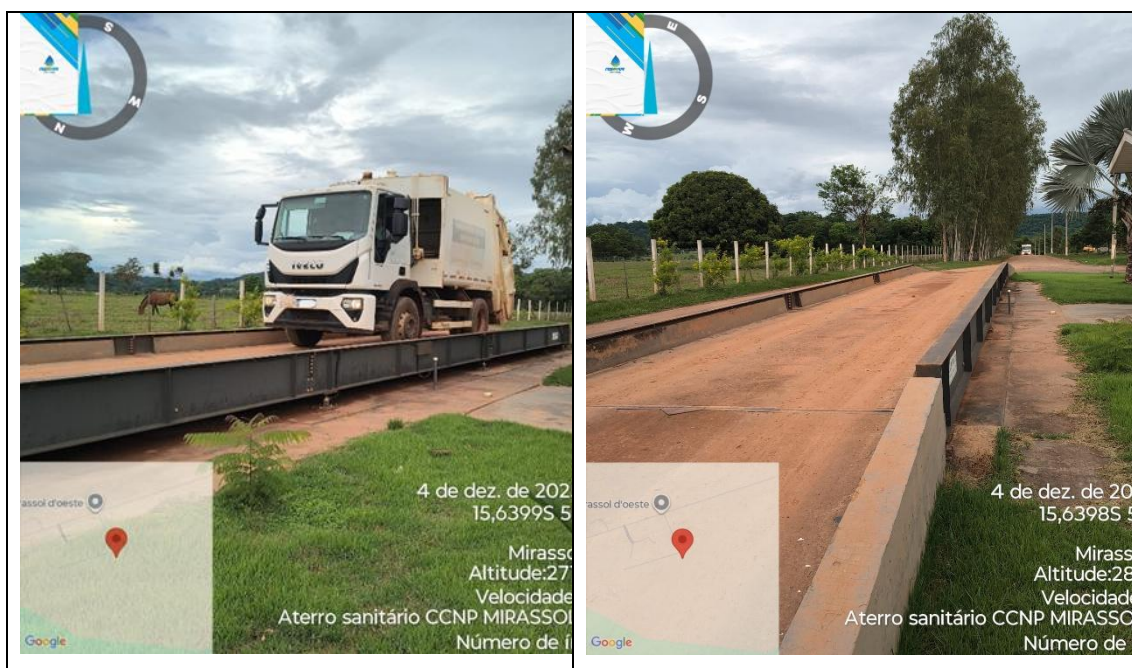
Figura 7 - FONTE: Fiscalização Agerr Pantanal (2025).
