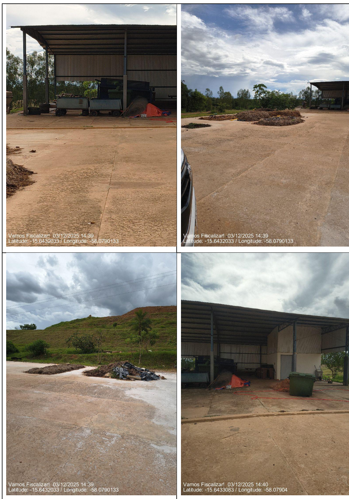
Figura 8 - FONTE: Fiscalização Agerr Pantanal (2025).
