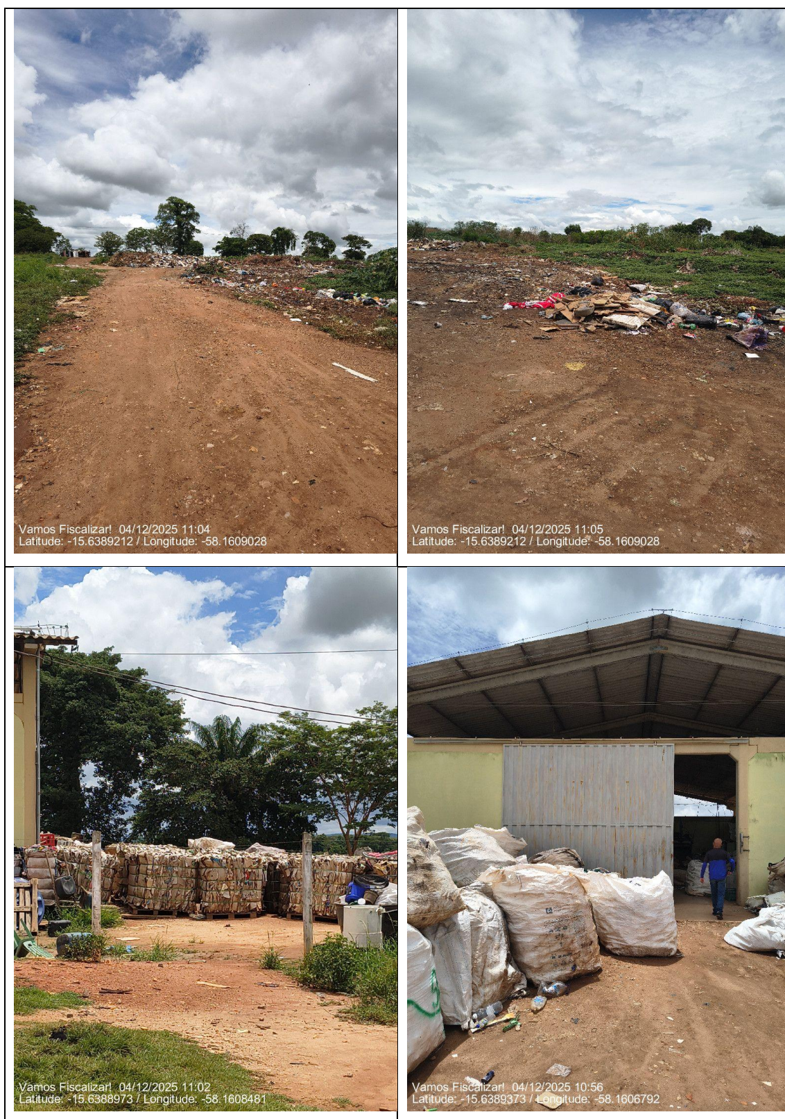
Figura 19 - FONTE: Fiscalização Agerr Pantanal (2025).
