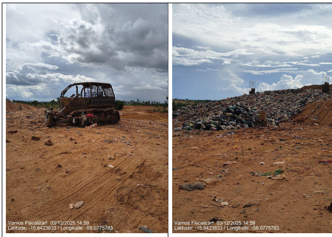
Figura 9 - FONTE: Fiscalização Agerr Pantanal (2025).
