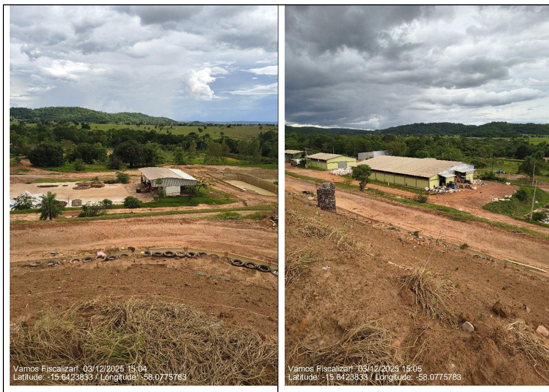
Figura 12 - FONTE: Fiscalização Agerr Pantanal (2025).
