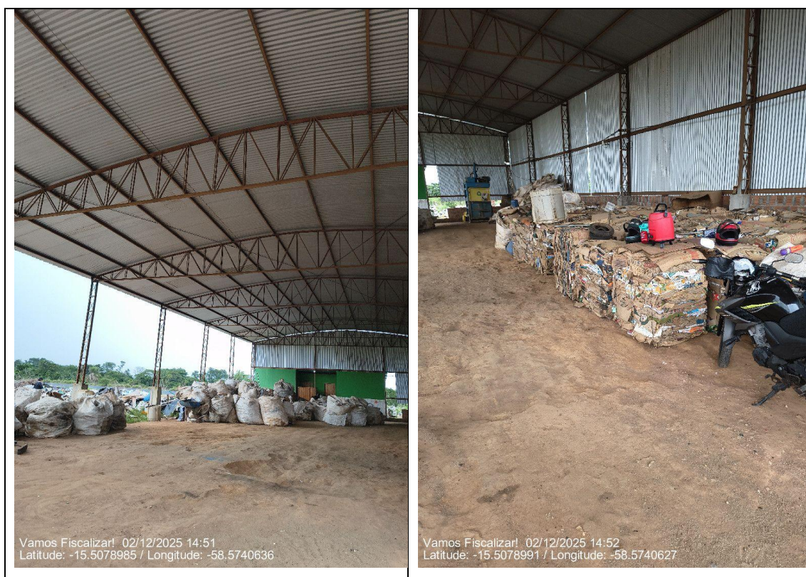
Figura 15 - FONTE: Fiscalização Agerr Pantanal (2025).
