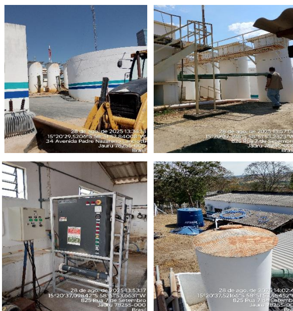
Figura 02: identificação da área da ETA de Jauru.
