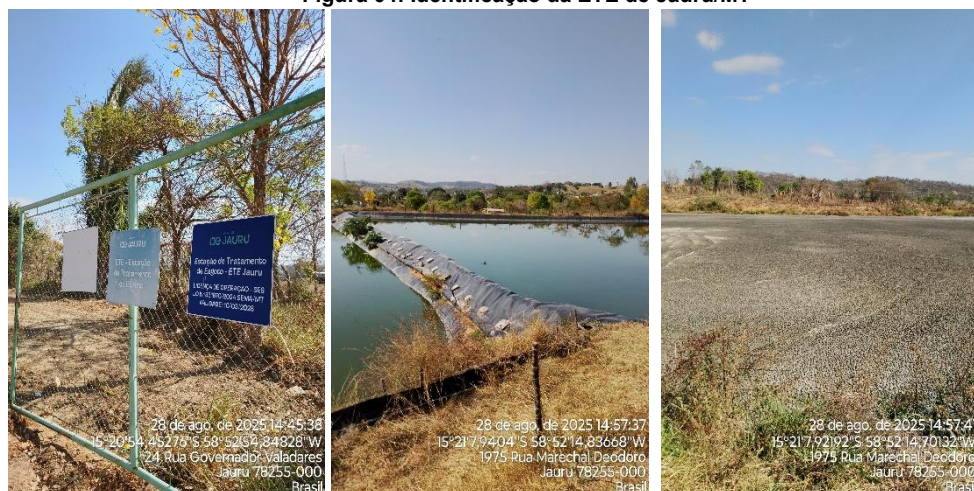
Figura 04: Identificação da ETE de Jauru/MT
