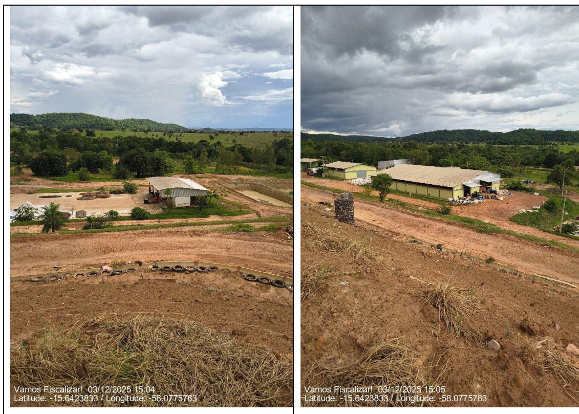
Figura 12 - FONTE: Fiscalização Agerr Pantanal (2025).
