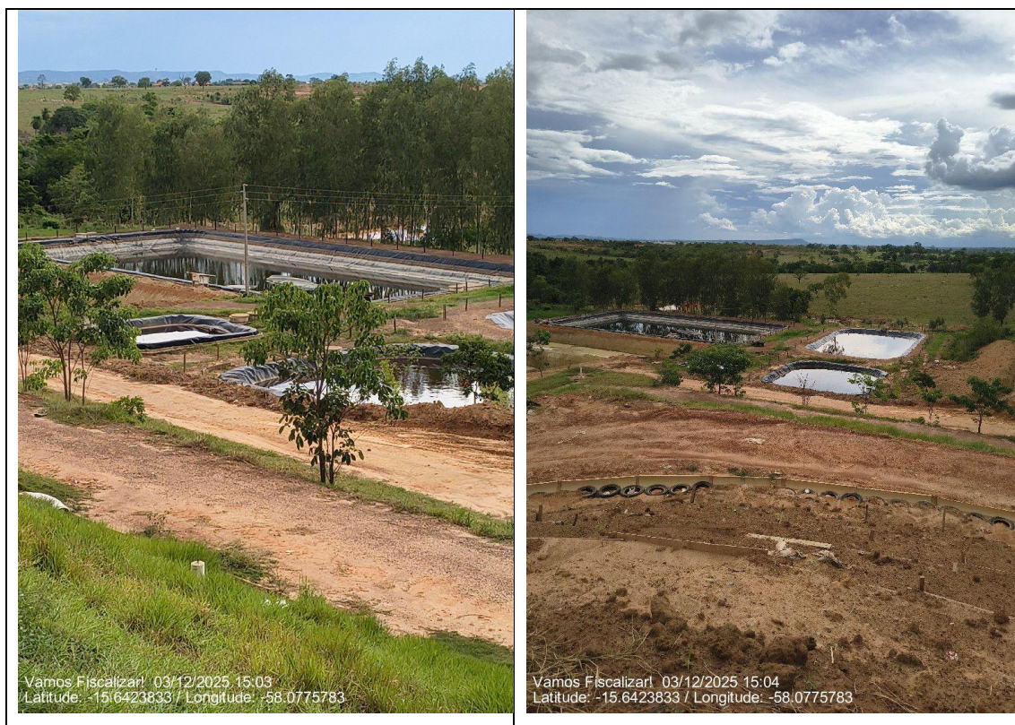
Figura 11 - FONTE: Fiscalização Agerr Pantanal (2025).
