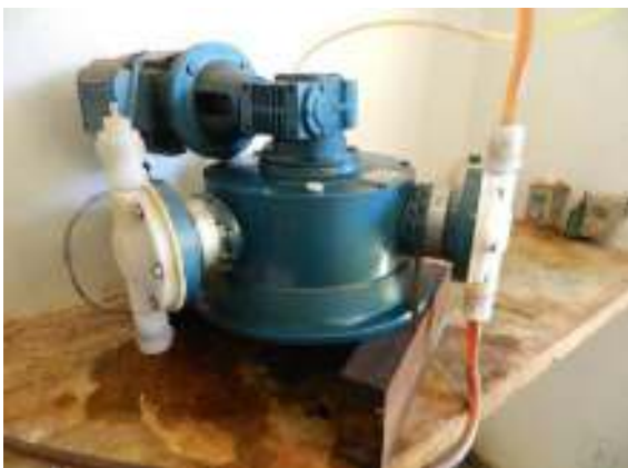
Figura 47- bomba dosadora
