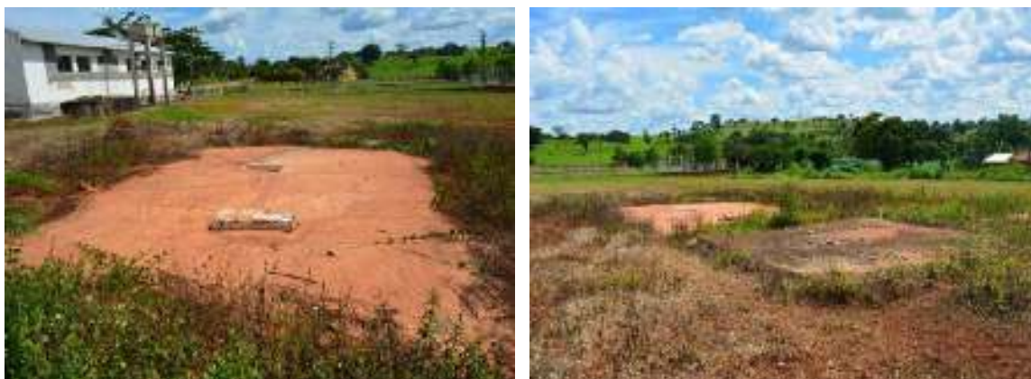
Figura 85 - Vista da fossa para Resíduos de Saúde
