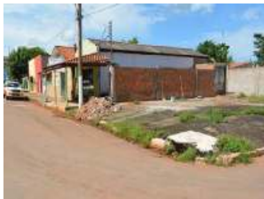
Figura 60 - entulho acima boca de lobo de passeio
