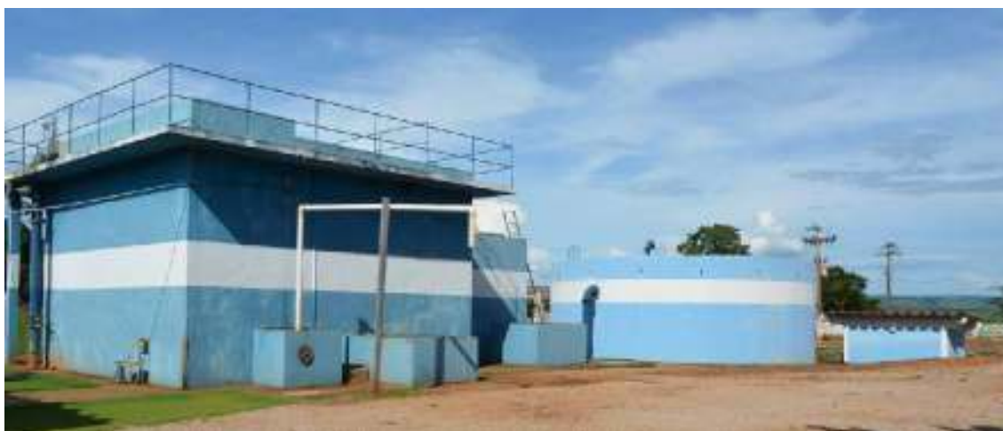
Figura 22 - Vista da E.T.A Convencional
