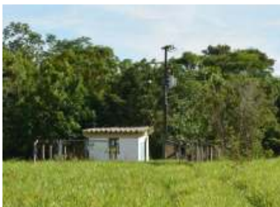
Figura 40 - Instalações de Apoio – captação
