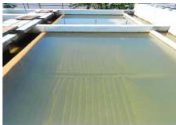
Figura 45-Decantador
