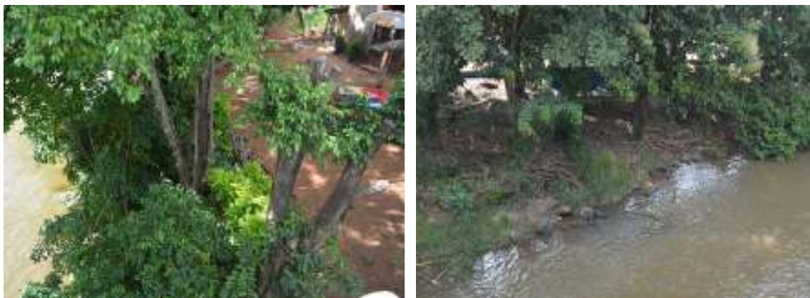
Figura 58 - Construções em área de risco/APP
