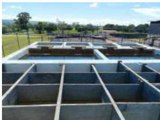
Figura 46 - Vista superior da ETA
