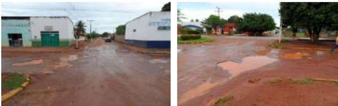
**Figura 39 vista de vias pavimentadas com presença de buracos**
