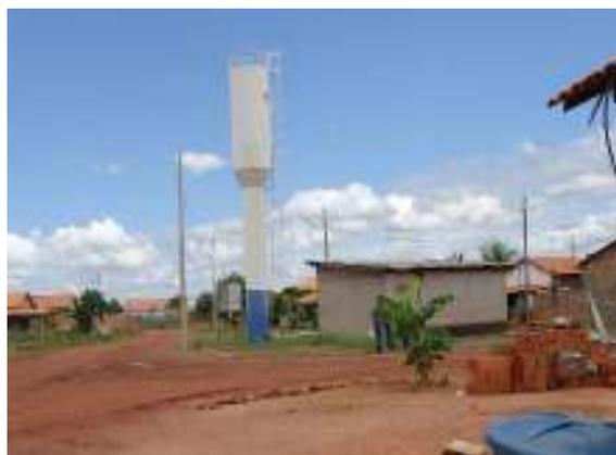
Figura 27 - Reservatório de 51 m<sup>3</sup>
