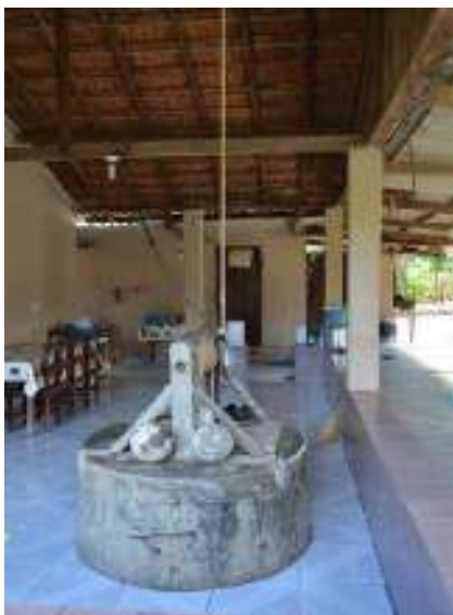
Figura 36 – Novo São José sistema individual de abastecimento poço cacimba
