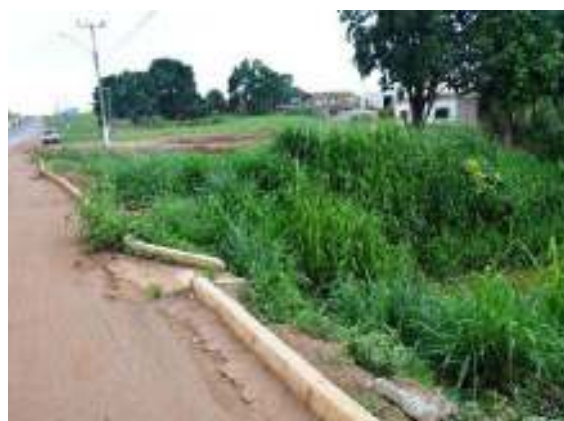
Figura 51 - Drenagem da MT 170- Saída d'água
