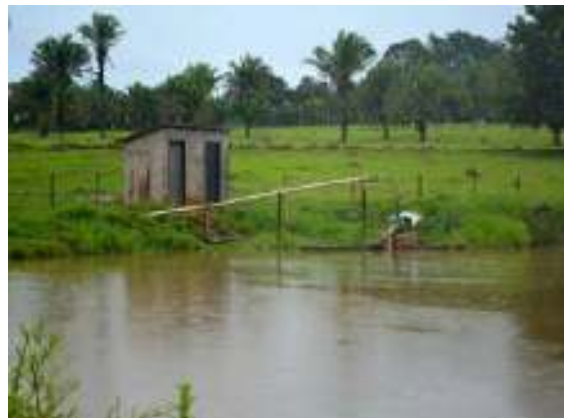
Figura 23 - Novo ponto de Captação superficial
