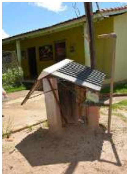
Figura 34 -poço nº 08 sem bomba na escola em Boa União
