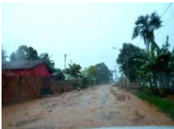
Figura 52 – Escoamento de água de chuva em via não pavimentada.
