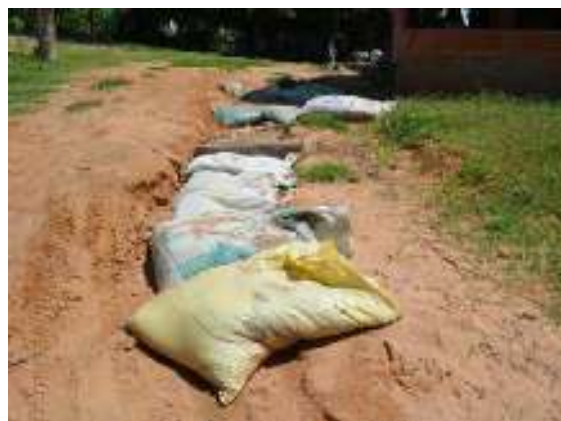
Figura 65 - Sacos de areia utilizados para conter erosão em Boa União.
