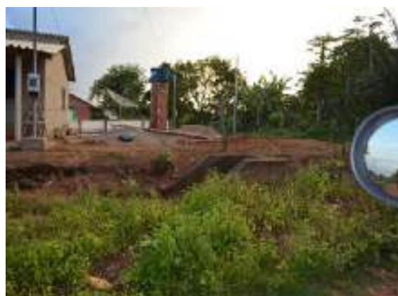
Figura 59 - Bueiro em São José do Pingador
