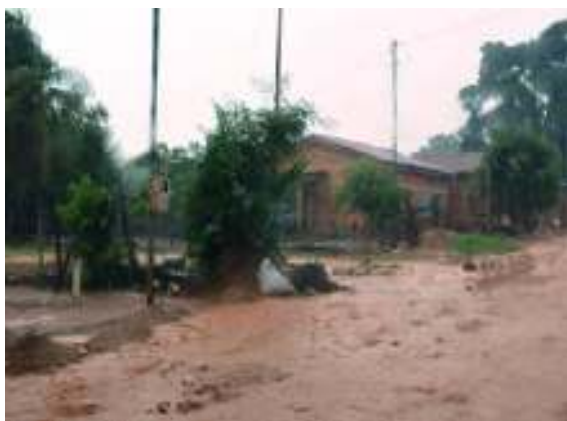
Figura 54 - Alagamento da via devido a ausência de sistema de drenagem
