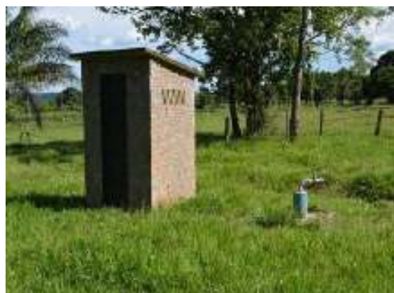
Figura 37 - Novo são José poço perfurado pela prefeitura aguardando para entrar em funcionamento.
