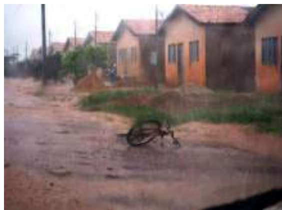
Figura 53 -Conjunto habitacional popular sem dispositivos de drenagem de águas pluviais
