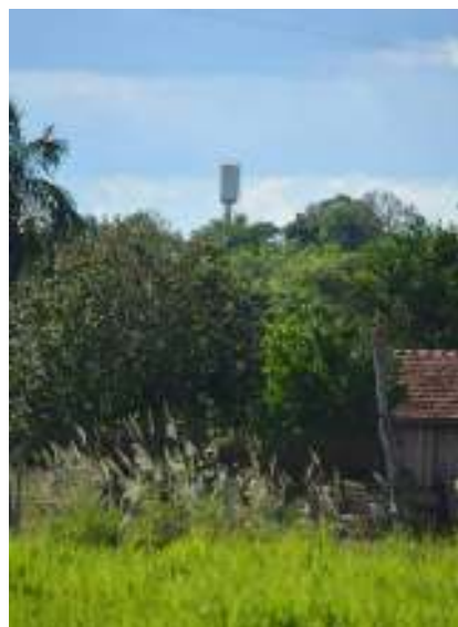
Figura 39 - Reservatório em Vila Sarizal
