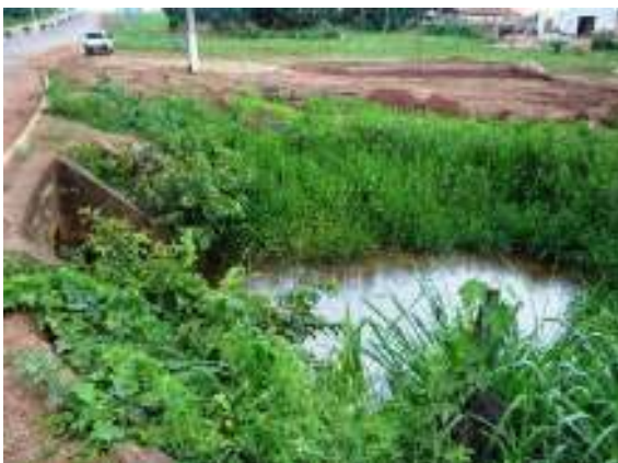
Figura 60– Bueiro celular na MT170 Córrego sem denominação
