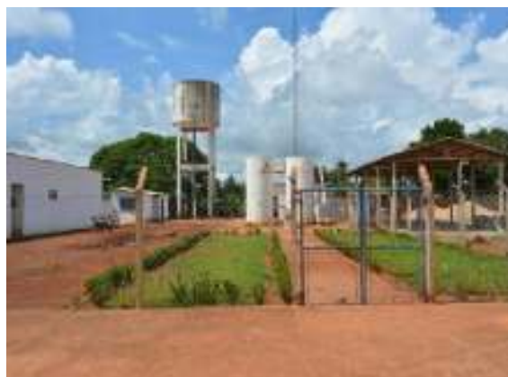
Figura 27 – Departamento de Água e Esgoto do município
