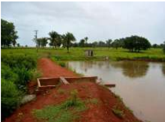
Figura 25– Barramento da captação
