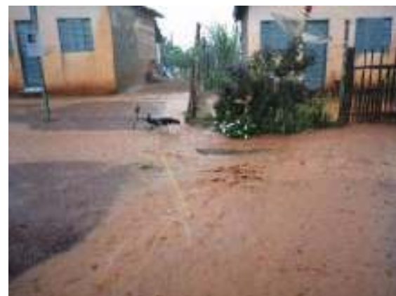
Figura 55 – Ponto de acúmulo de águas pluviais.
