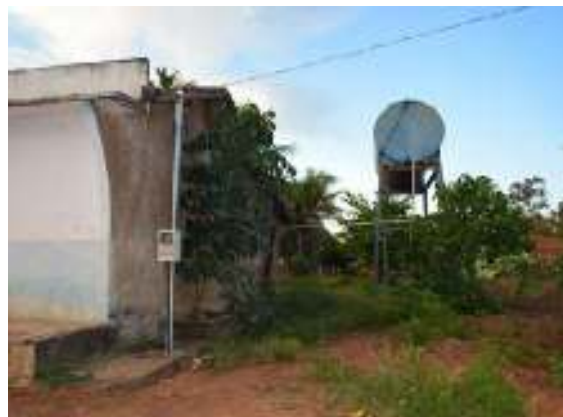
Figura 41 - Reservatório desativado em São José do Pingador
