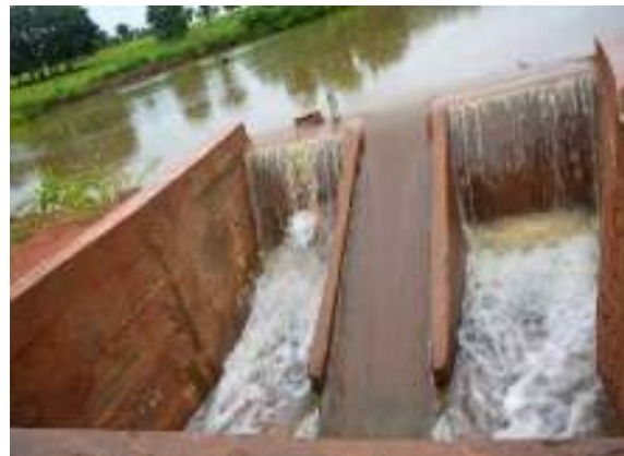
Figura 26 - Vertedor retangular da barragem
