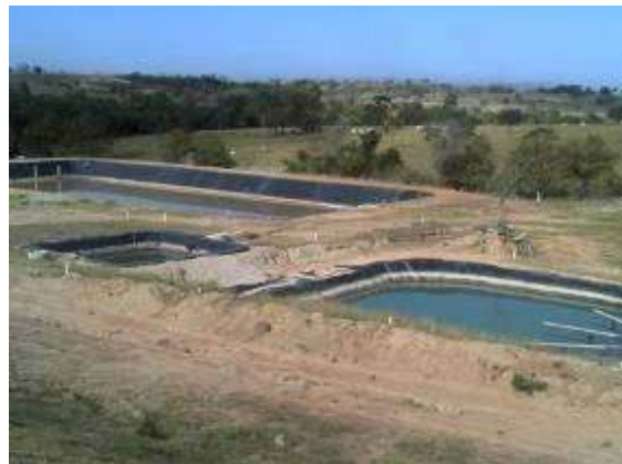
Figura 77 – Sistema de tratamento de chorume do aterro sanitário consorciado.
