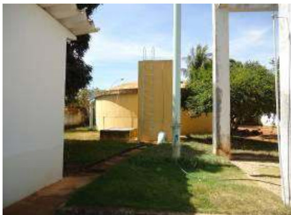
Figura 41 – Reservatório apoiado.
