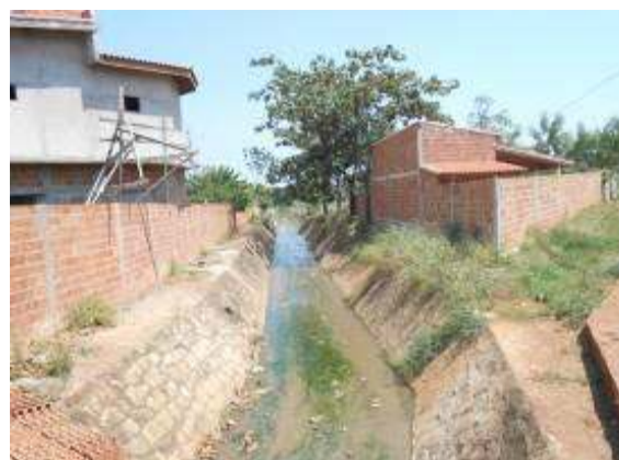
Figura 57 – Margem ocupada com residências e nova construção em andamento.
