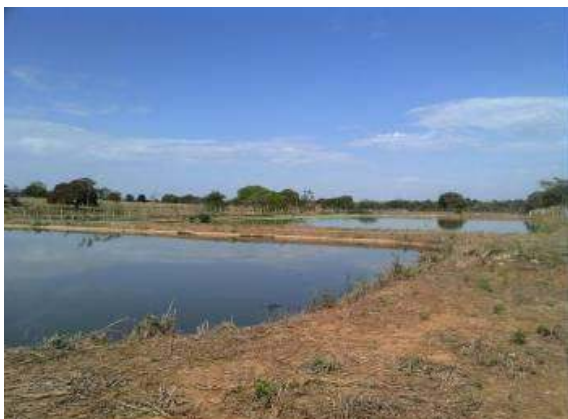
Figura 52 – Sistema de Tratamento de Esgoto Lagoa anaeróbia e de facultativa
