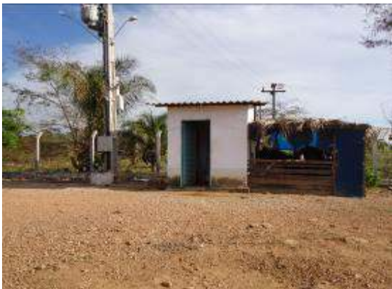
Figura 33 – Instalações de apoio.
