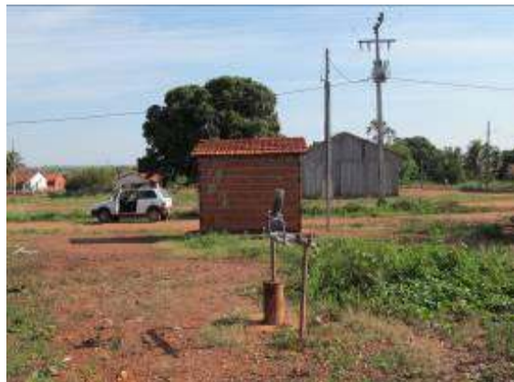
Figura 23 – Poço e clorador.
