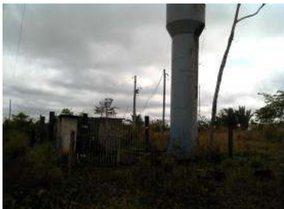
Figura 27 – Sistema de abastecimento.
