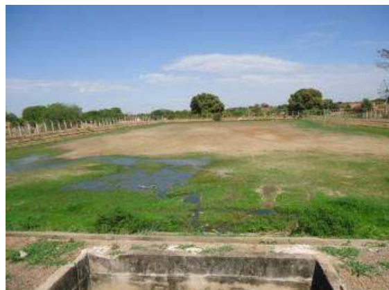
Figura 53 – Sistema de Tratamento de Esgoto – Lagoa de maturação
