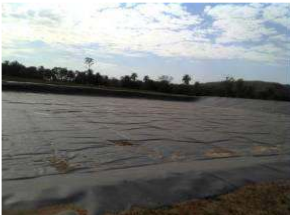
Figura 76 – Vala impermeabilizada do aterro sanitário consorciado.
