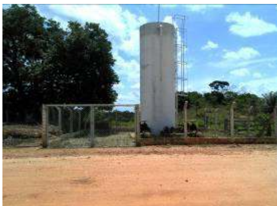
Figura 36 – Elevat de Água Bruta 01.
