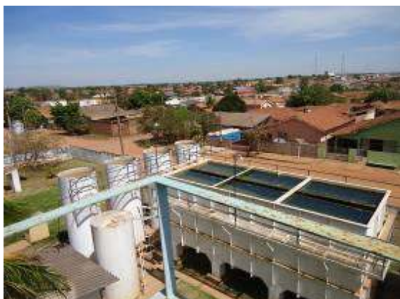
Figura 38 – ETA metálica.
