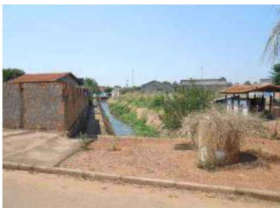
Figura 56– Canalização em seção aberta do Córrego Queixada.
