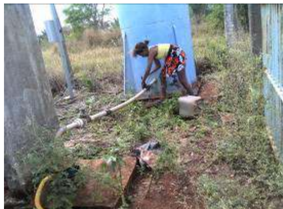
Figura 28 – Moradora fazendo reparo.
