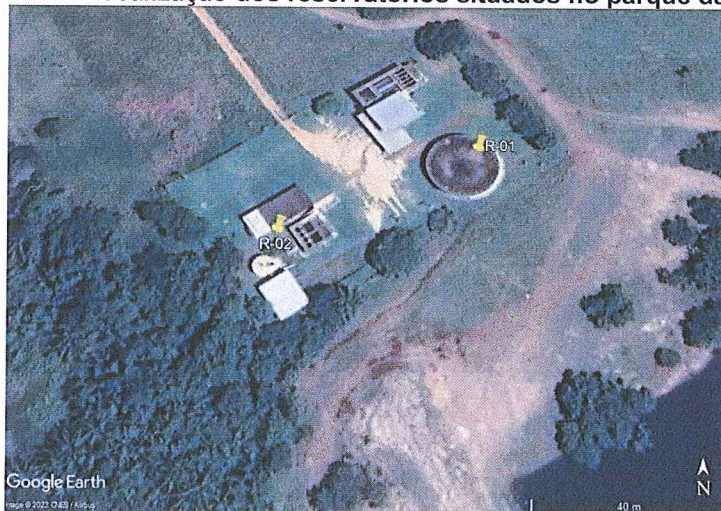
Figura 11: Localização dos reservatórios situados no parque da ETA
