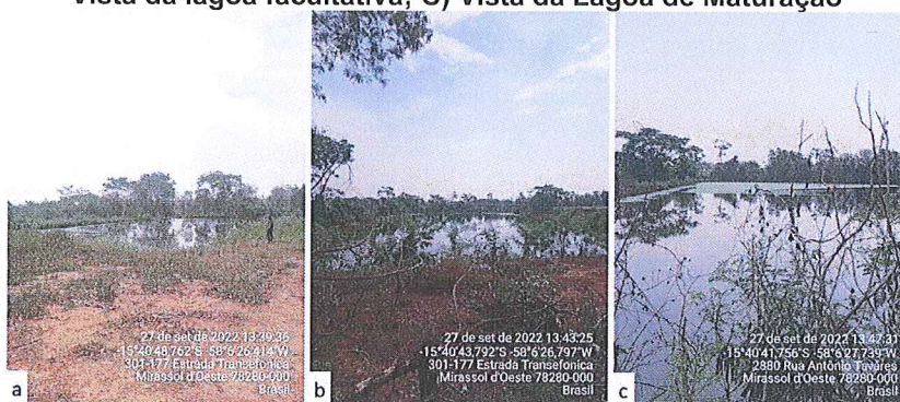
Figura 14: Registro fotográfico da ETE de Mirassol d'Oeste: a) Vista da lagoa anaeróbia; b) Vista da lagoa facultativa; C) Vista da Lagoa de Maturação
