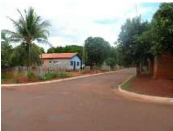
Figura 43 – Via no distrito de Monte Castelo
