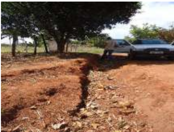
Figura 49 – Erosão causada pelo esc. superficial em Monte Castelo.
