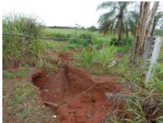
Figura 50 – Erosão em área de chácara em Monte Castelo.
