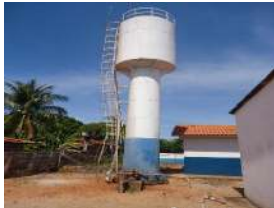
Figura 27 – Reservatório Monte Castelo
