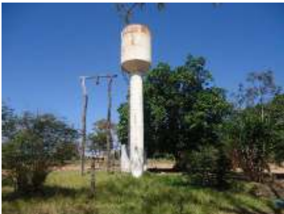
Figura 26 – Reservatório Serra Linda
