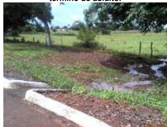
Figura 40 – Destino final após encaminhamento da boca de lobo.
