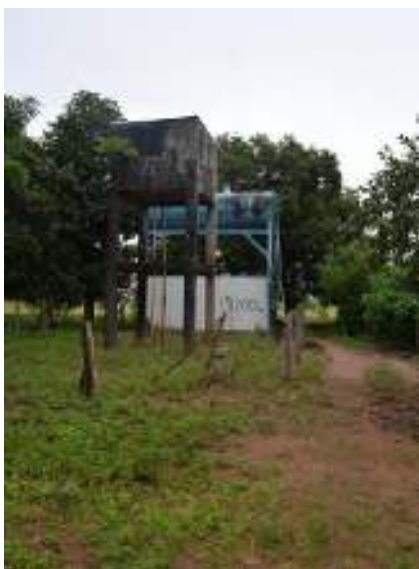
Figura 22 – reservatório de 0,65m 3 e 19,2m 3 respectivamente
