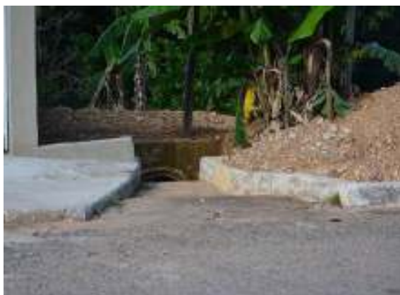
Figura 68– ponto de dissipação das águas captadas no sistema de drenagem.
