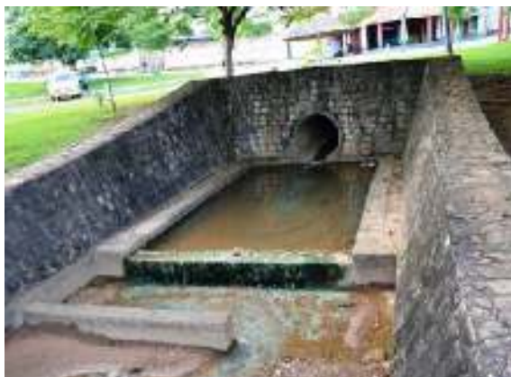
Figura 68– ponto de dissipação das águas captadas no sistema de drenagem.
