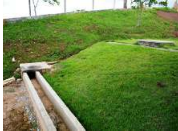
Figura 41 – Sistema de drenagem da área do DAE
