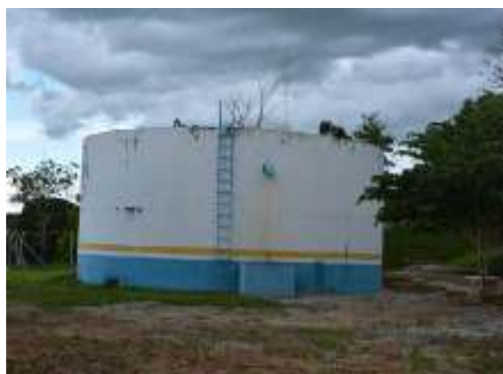
Figura 51 – Reservatório em concreto armado
