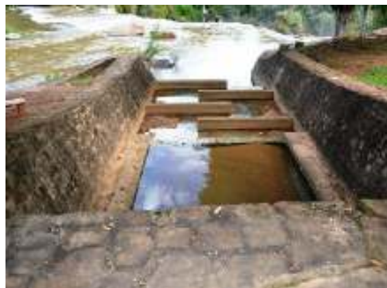
Figura 69– Lançamento das águas das chuvas na cachoeira.
