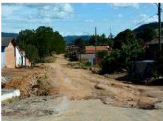
Figura 72 – fim de asfalto e início de via não pavimentada início de ravinas
