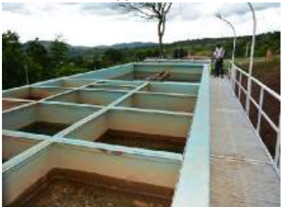
Figura 43– Floculador tipo chicanas
