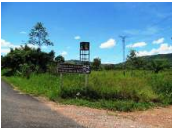
Figura 24 – Caixa d'água da Comunidade de Salto das Nuvens
