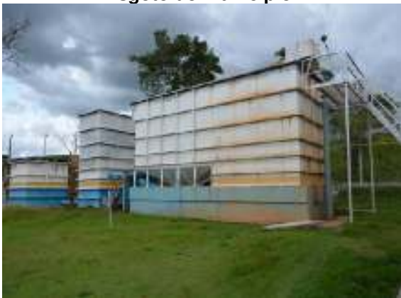
Figura 42 – ETA compacta
