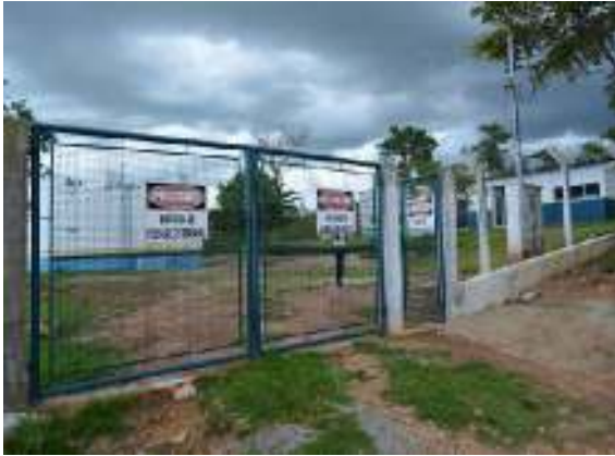
Figura 40– Departamento de Água e Esgoto do município
