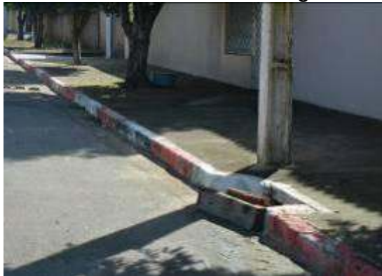
Figura 32– Boca de lobo com aparato para direcionamento da água de chuva.
