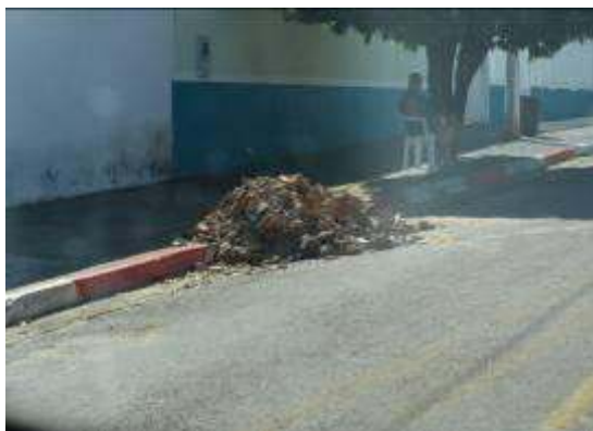
Figura 52 – RCD disposto para coleta sem acondicionamento em via pública.
