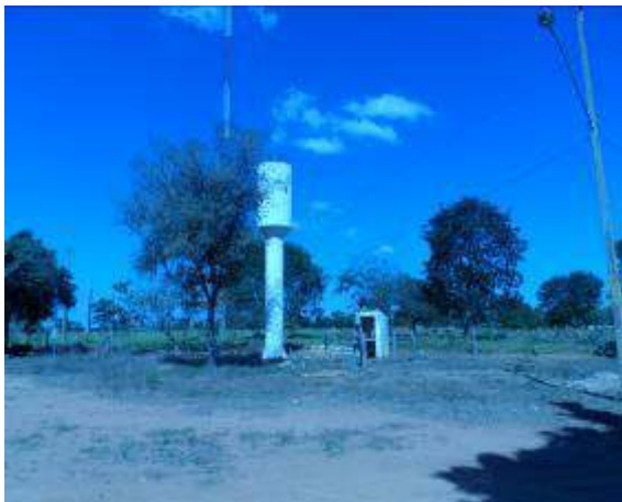
Figura 20 – Caixa d'água localizada junto a igreja.
