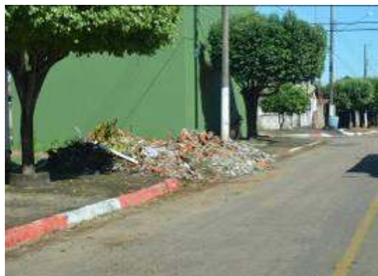
Figura 52 – RCD disposto para coleta sem acondicionamento em via pública.
