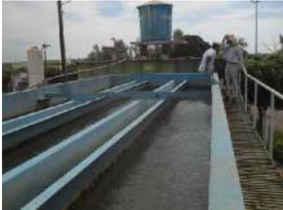
Figura 29 – ETA metálica.
