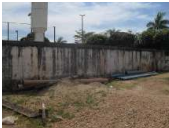
Figura 28 – Área de Estocagem dos Materiais
