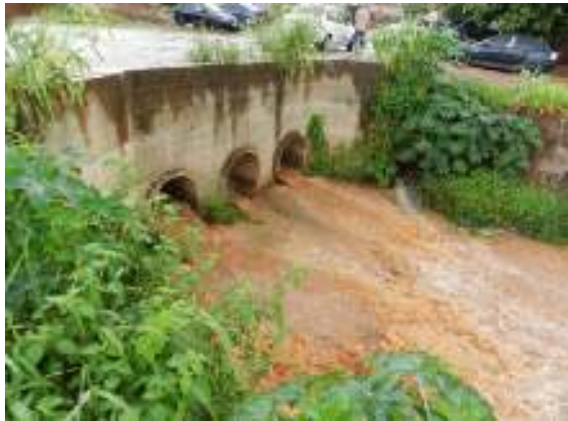
Figura 48 – Bueiro Celular sobre o córrego Quexada.
