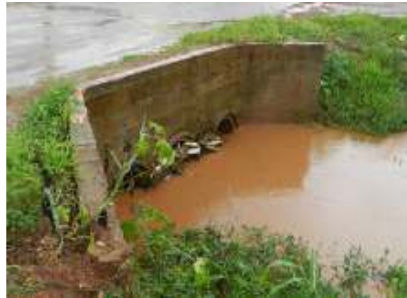
Figura 49 – Bueiro Celular sobre o córrego do Bacurí.
