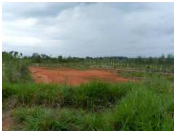
Figura 42 – Estação de Tratamento de Esgotos – Lagoa de Maturação
