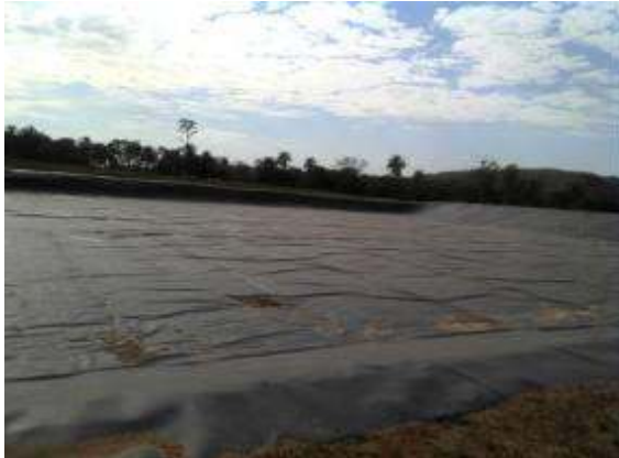
Figura 57 – Vala impermeabilizada do aterro sanitário consorciado.
