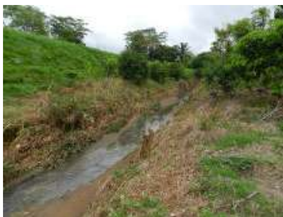
Figura 38 – Córrego Bacurí a jusante do bueiro.
