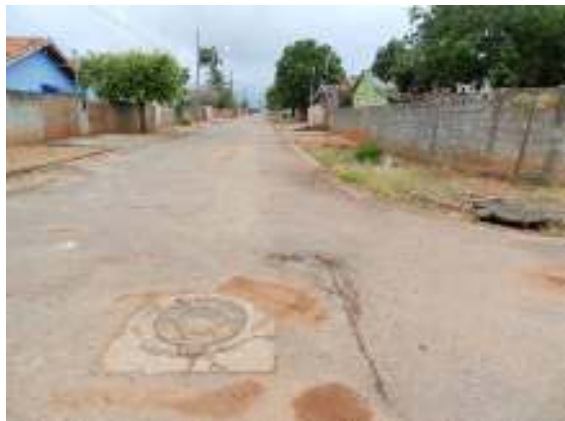
Figura 36 – Final da avenida D, rede de esgoto e drenagem presentes
