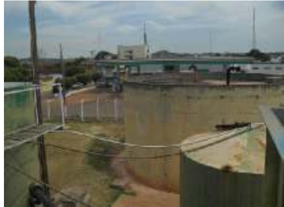
Figura 30 – ETA, Câmara de Contato e Reservatório apoiado.
