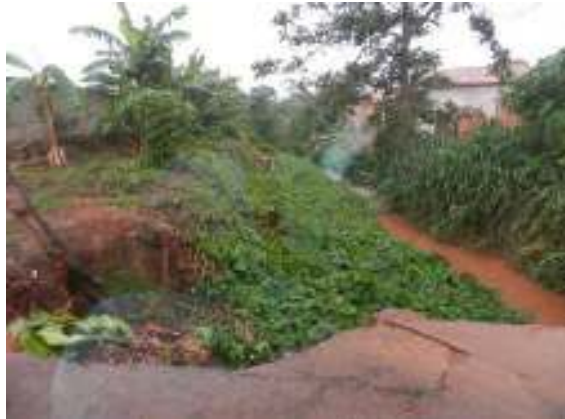
Figura 51 – Erosão em via pavimentada com apresentando queda de pavimento e parte da travessia sobre bueiro.
