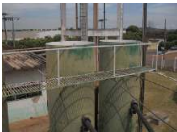
Figura 25 – Filtros Ascendentes em Chapa Metálica
