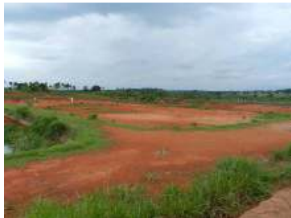
Figura 41 – Sistema de Tratamento de Esgoto – Lagoa Facultativa
