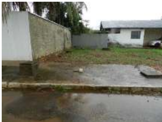
Figura 44 – Fossa séptica da Vila Manati
