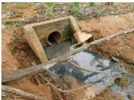
Figura 37 – Bueiro celular – Fim da rede de drenagem da rua D (~30 metros da ETE)
