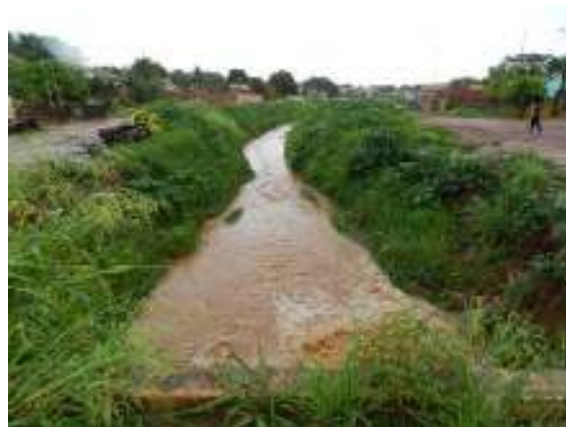
Figura 50 – Córrego .da Garrucha, em leito natural
