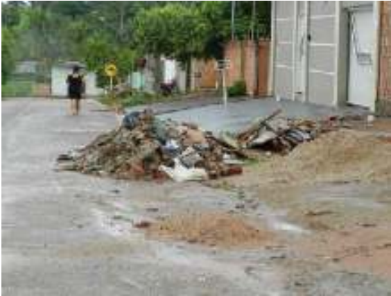
Figura 59 – RCD disposto em via pública pavimentada.
