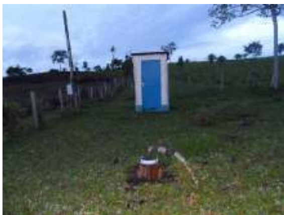
Figura 28 – Poço tubular para abastecimento.
