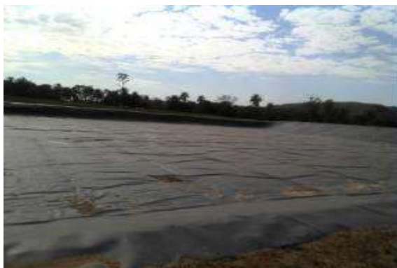
Figura 81 – Vala impermeabilizada do aterro sanitário consorciado.
