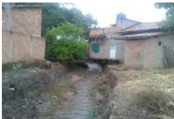
Figura 63 – residência sobre o leito do córrego
