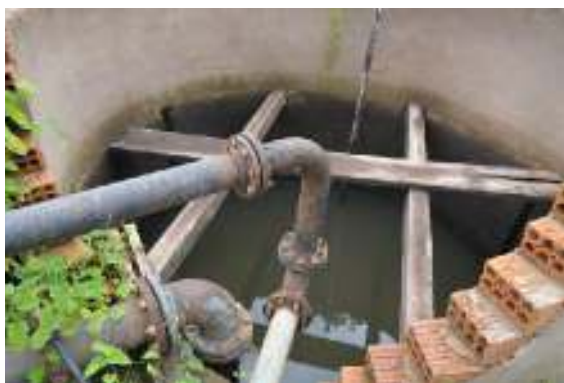
Figura 33 – Poço de Sucção para adutora.
