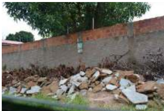
Figura 84 – RCD disposto em via pública pavimentada – região central da cidade
