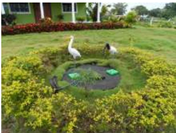
Figura 26 – Poço tubular para abastecimento.
