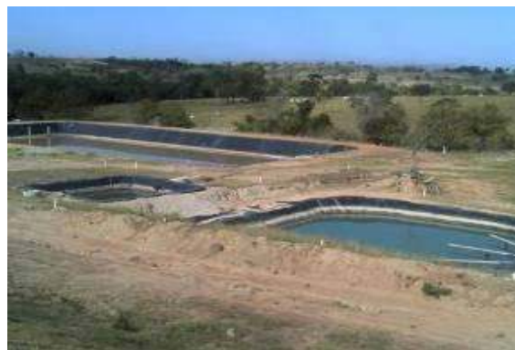
Figura 82 – Sistema de tratamento de chorume do aterro sanitário consorciado.
