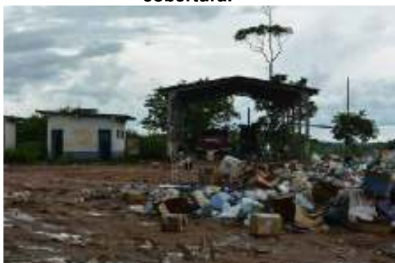
Figura 79 – Galpão e instalações abandonadas.
