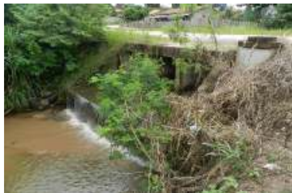
Figura 62 – Ponte e Bueiro celular no córrego da Saúde
