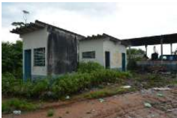
Figura 75 – Guarita de entrada do lixão
