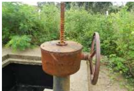
Figura 54 – Comporta da entrada da EEE.
