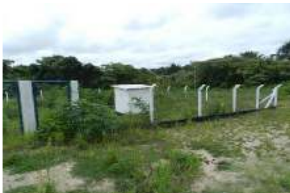
Figura 47 – Vista Geral da Estação Elevatória
