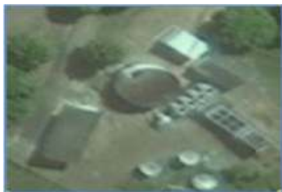
Figura 37: Vista Superior ETA – Jauru (fonte: ÁGUAS DE JAURU)
