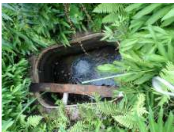
Figura 30 – Mina d'água para abastecimento.
