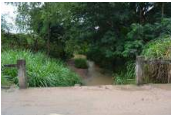
Figura 61– Canalização em seção aberta do Córrego da Saúde
