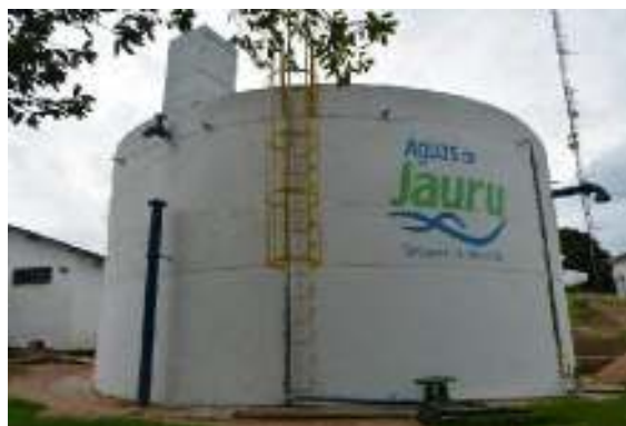
Figura 44 - Vista Reservatório ETA RAP -01
