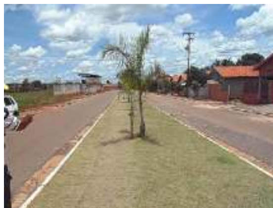
Figura 64 – Limpeza do canteiro e via.
