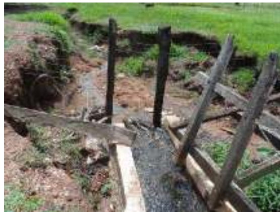
Figura 43 – Canal de drenagem sem dissipador
