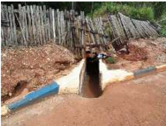
Figura 42 – entrada do escoamento superficial ao córrego água suja
