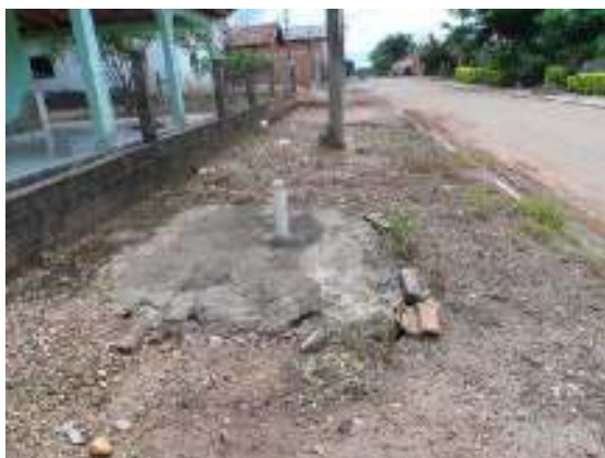
Figura 35 – sumidouros na calçada
