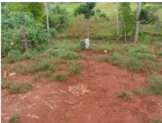
Figura 50 – Erosão em área rural – caminhamento das águas da estrada dentro de propriedade particular
