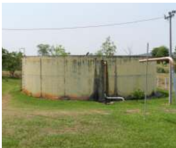
Figura 48 – Reservatório 1 (ETA) - concreto apoiado.
