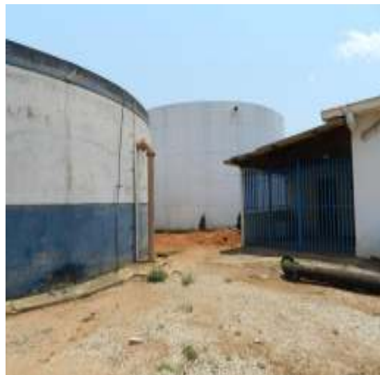
Figura 51 – Reservatórios localizados na Praça São Paulo
