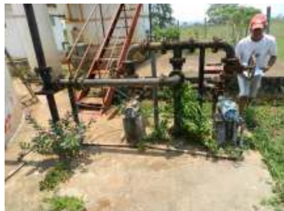
Figura 88 – Pressurizadora desativada
