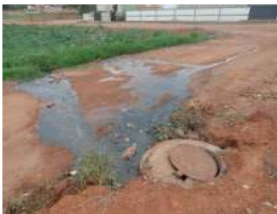
Figura 99 – PV danificado na estrutura
