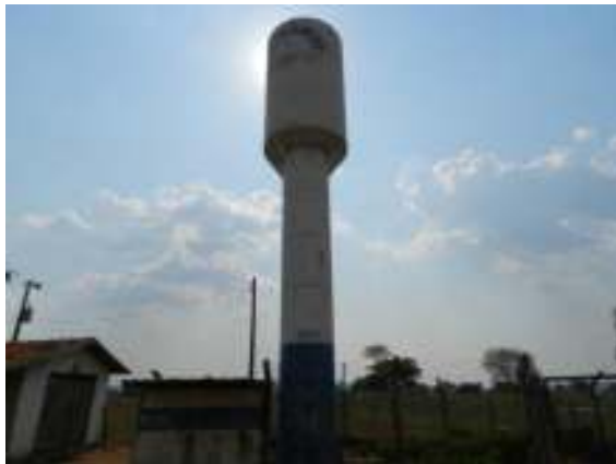
Figura 69 – reservatório 60m 3
