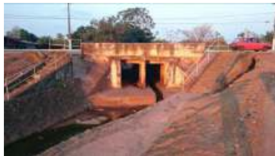
Figura 110 – descida d'água junto a sargeta.
