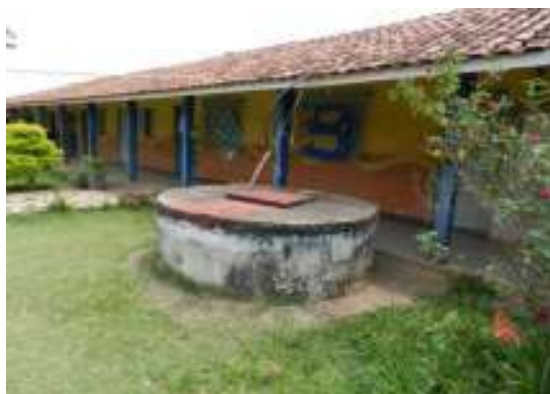
Figura 56 – Cisterna da escola
