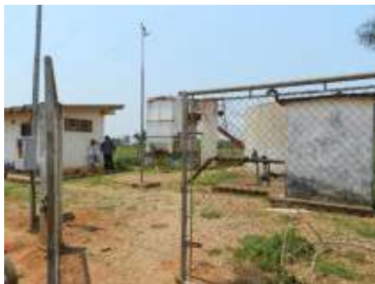
Figura 92 – Vista geral da ETA
