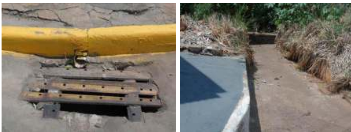
Figura 107 – Boca de lobo com grade.
