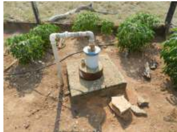
Figura 70 – poço tubular
