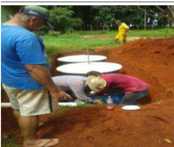
Figura 103 – Instalação da biofossa zona rural
