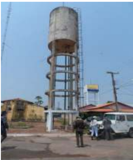
Figura 50 – Reservatório elevado Cohab Juruena
