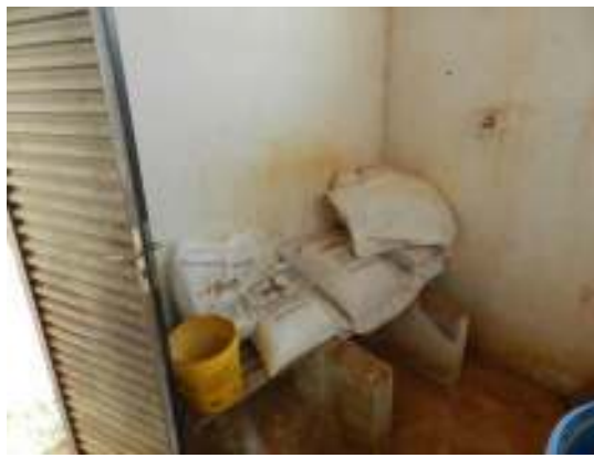
Figura 90 – Armazenamento do sulfato de alumínio
