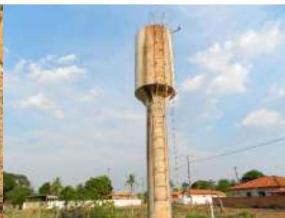
Figura 53 – Reservatório 8m 3
