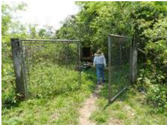
Figura 81 – Entrada da captação
