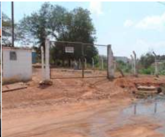
Figura 96 – Elevatória 12 de Outubro
