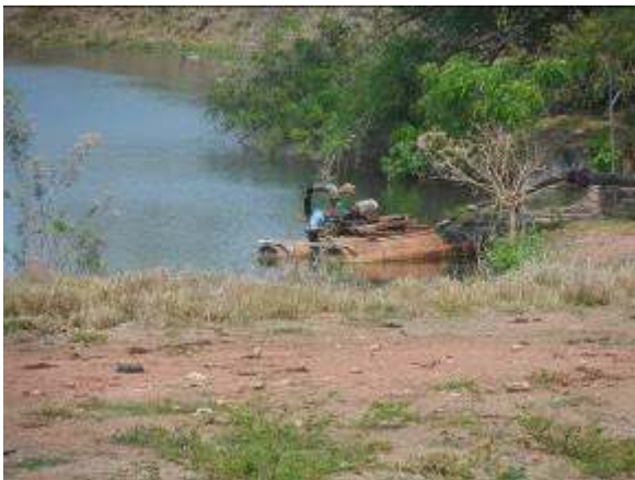
Figura 39– Vista da Captação do SIGLA
