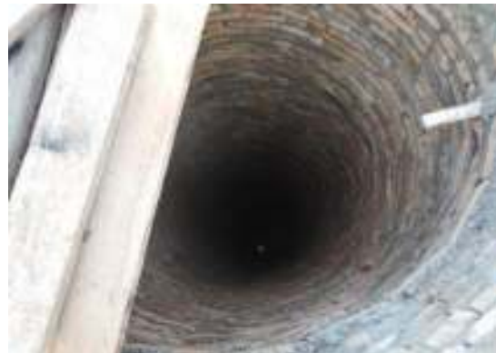
Figura 67 – Várias áreas em condições originais
