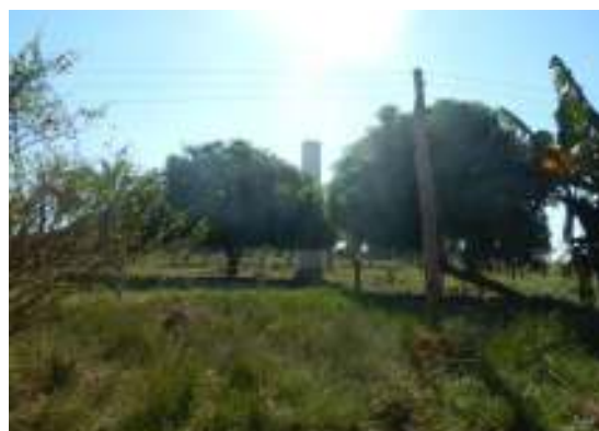
Figura 63 – Poço 2 e reservatório 2, localizado em terreno de assentado
