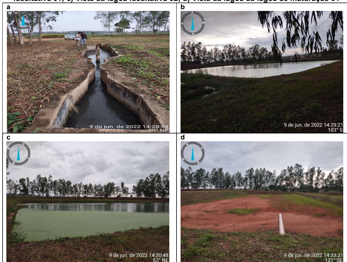
Figura 19: Registro fotográfico da ETE: a) Vista do tratamento preliminar; b) Vista da lagoa facultativa 01; c) Vista da lagoa facultativa 02; d) Vista da lagoa da lagoa de maturação 01
