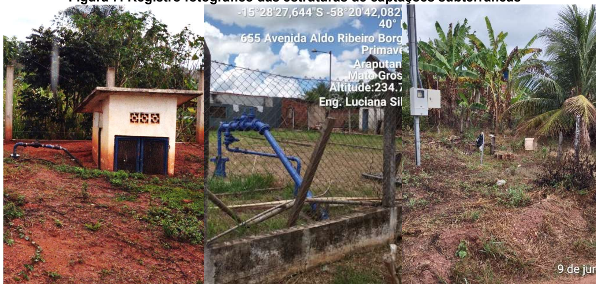
Figura 7: Registro fotográfico das estruturas de captações subterrâneas
