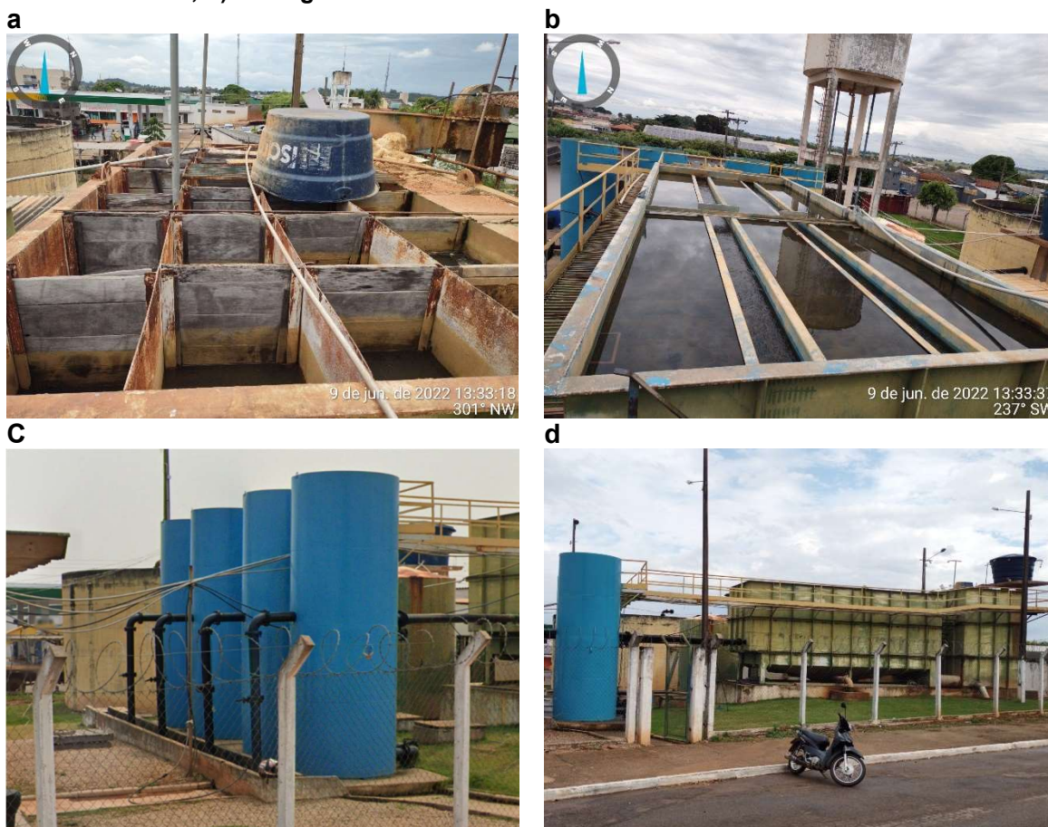
Figura 10: Registro fotográfico da ETA: a) Vista do floculador; b) Vista decantador c) Vista dos módulos do filtro; d) Vista geral da ETA.
