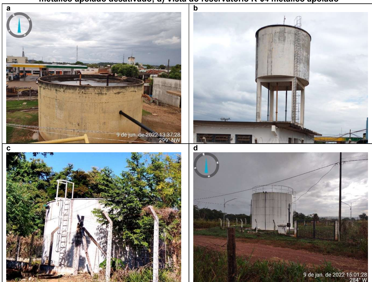
Figura 13: Registro fotográfico dos reservatórios: a) Vista do reservatório R-01 de concreto apoiado; b) Vista do reservatório R-02 de concreto elevado; c) Vista do reservatório R-03 metálico apoiado desativado; d) Vista do reservatório R-04 metálico apoiado
