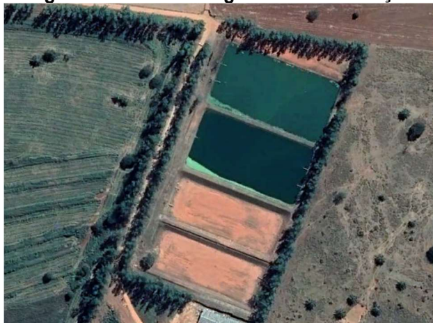
Figura 18: Vista das lagoas de estabilização
