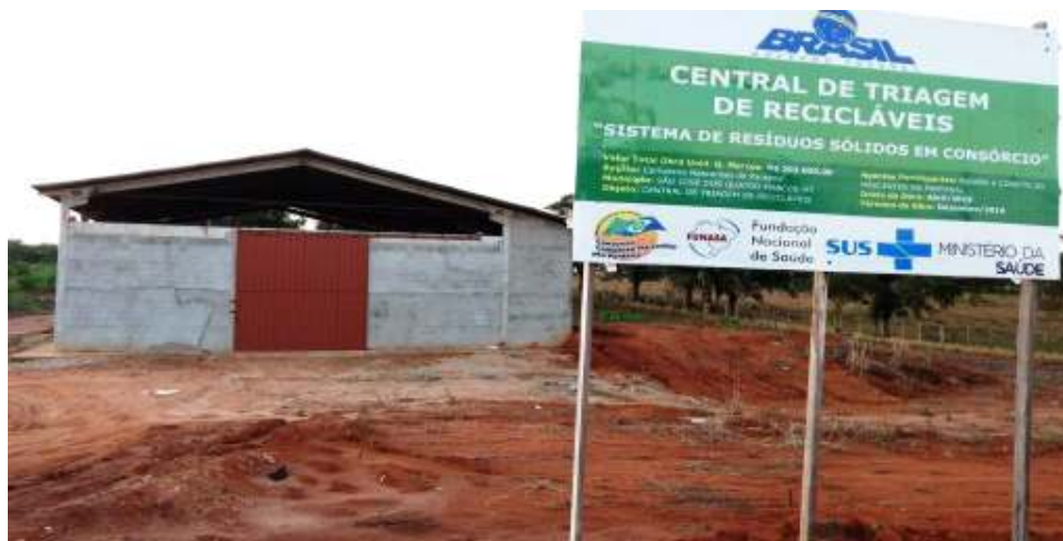
Em fase final de acabamento
