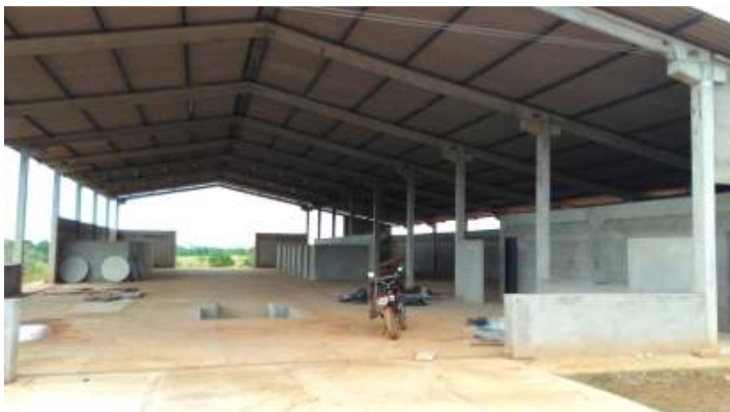
Em fase final de acabamento
