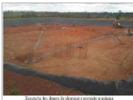
Figura 85 – Execução dos drenos
