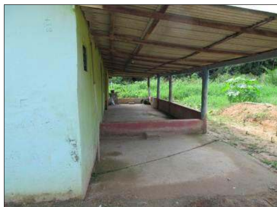
Figura 62 - Residências que ficam à margem da drenagem principal (com contenção).
