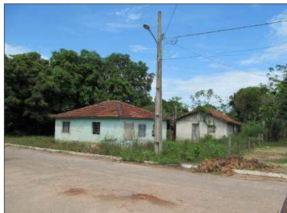
Figura 61 - Residências que ficam à margem da drenagem principal
