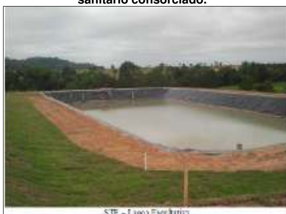
Figura 86 – Sistema de Tratamento de Efluente do Aterro Sanitário- Consórcio
