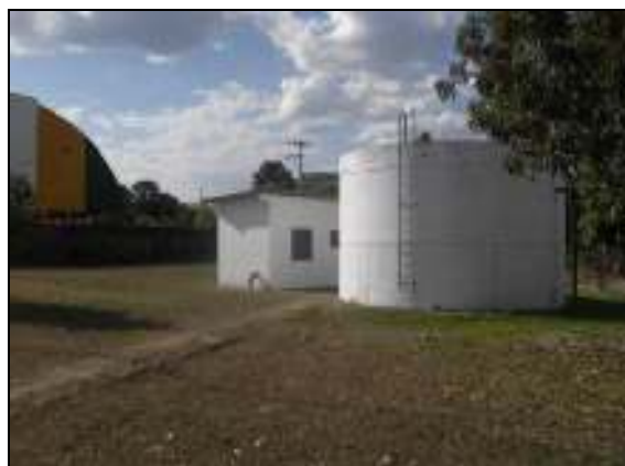
Figura 30 - Reservatório (capac. 100m 3 )
