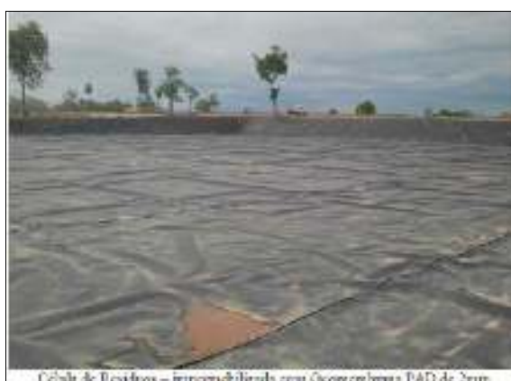
Figura 84 – Vala impermeabilizada do aterro sanitário consorciado.
