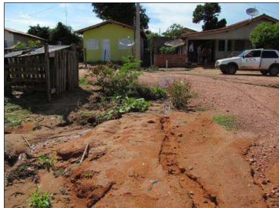
Figura 59 - Extravasamento de efluente
