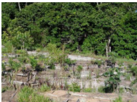
Figura 20– Recuperação "Boçoroca da Parede"..
